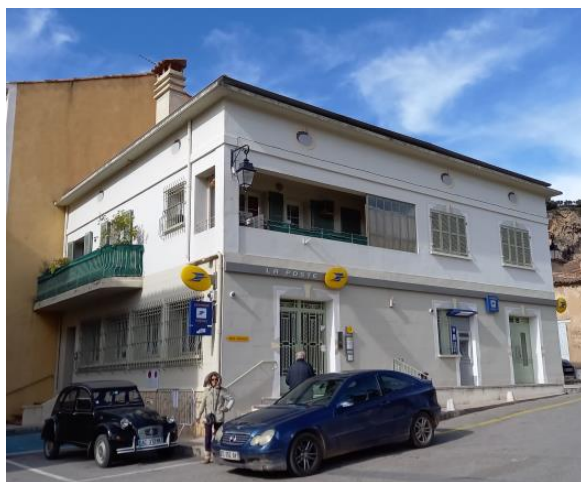
Bâtiment de La Poste présente des éléments art-déo
