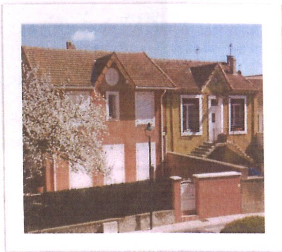
N°26 et 28 Rue de l'Eglise
