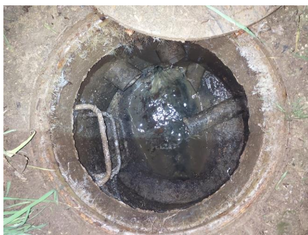
Figure 2 : Regards localisés dans l'ancien lit du Réal Vieux
