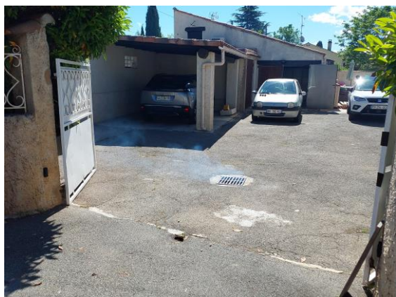
Figure 28: Grille connectée à l'assainissement
