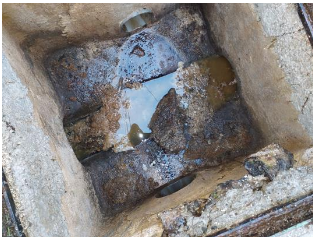
Figure 45 : Défaut d'écoulement
