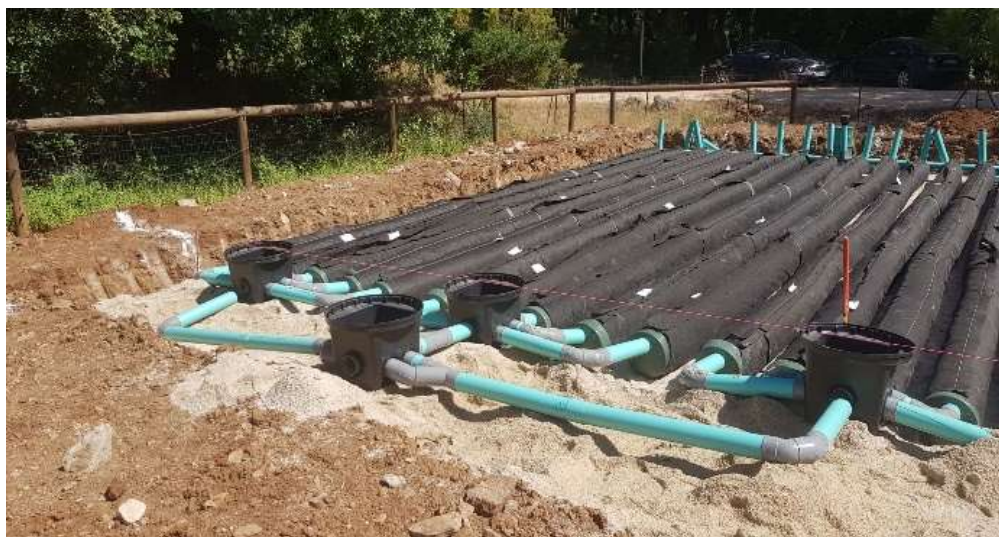
Zone d'infiltration avant remblaiement
