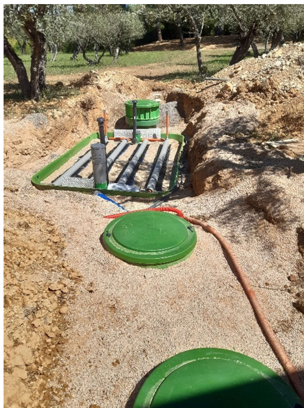
Pose d'un filtre compact drainé par épandage à massif de zéolite
