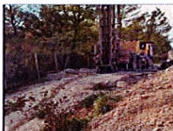
Forage de reconnaissance F4 des plantiers Commune de Cotignac
